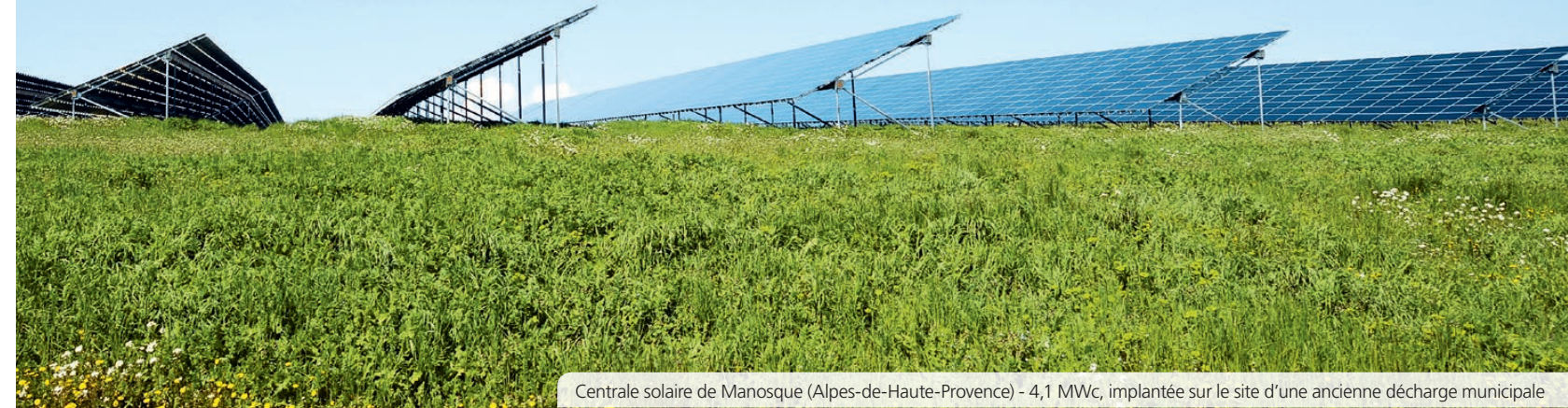
Centrale solaire de Manosque (Alpes-de-Haute-Provence) - 4,1 MWc, implantée sur le site d'une ancienne décharge municipale
